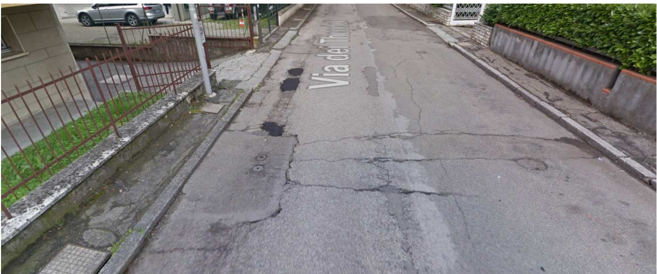
Tipologia di ammaloramento dovuta a scavi per le riparazioni dei sottoservi
