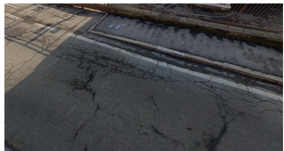
Tipologia di pavimentazione ammalorata superficialmente
