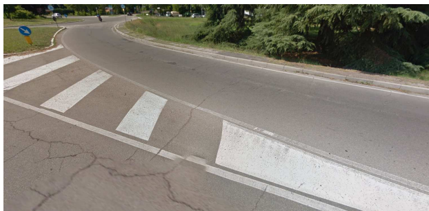
Tipologia di pavimentazione ammalorata superficialmente
