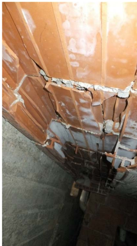
FOTO 10: Vista laterizio sfondellato, piano interrato
