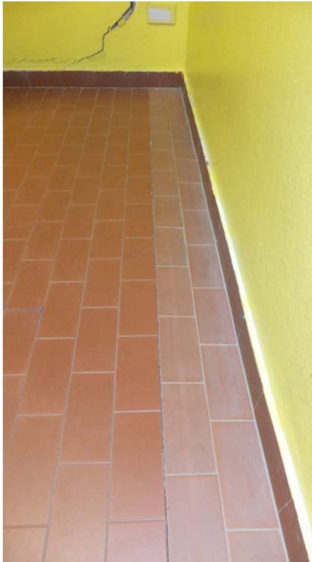
FOTO 13: Vista solaio lesionato aula 4, piano terra
