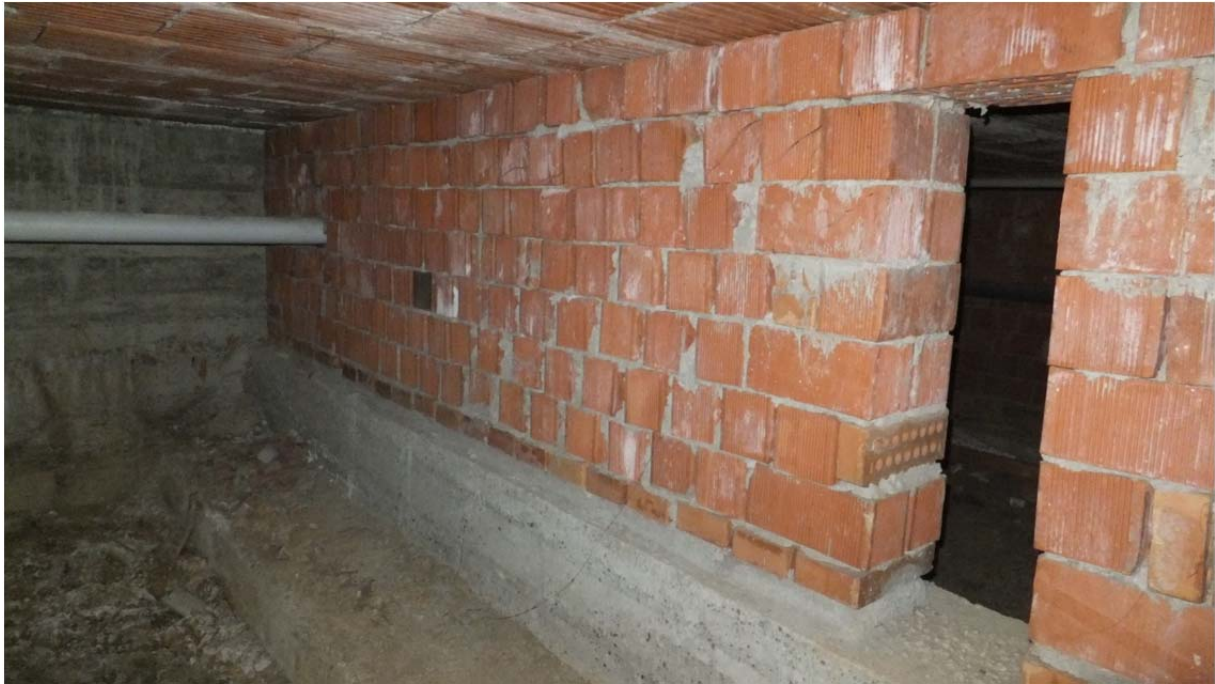
FOTO 7: Vista vano da chiudere su parete a due teste, piano interrato
