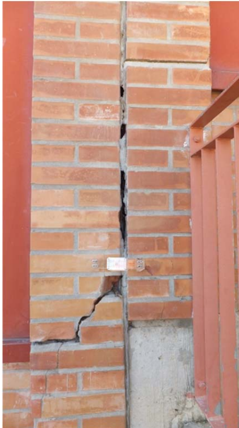
FOTO 15: Vista pilastro esterno lesionato
