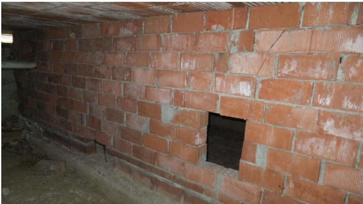
FOTO 8: Vista vano da chiudere su parete ad una testa, piano interrato
