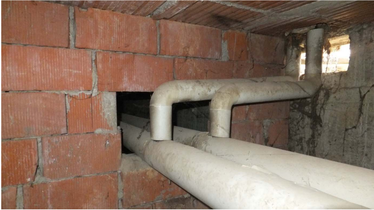
FOTO 3: Vista passaggio impianti su muratura portante, piano interrato
