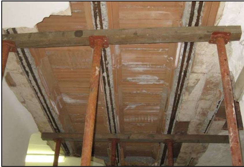
Esempio puntellamento solaio
