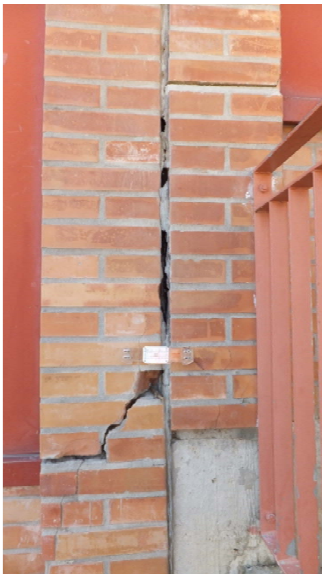
FOTO 15: Vista pilastro esterno lesionato
