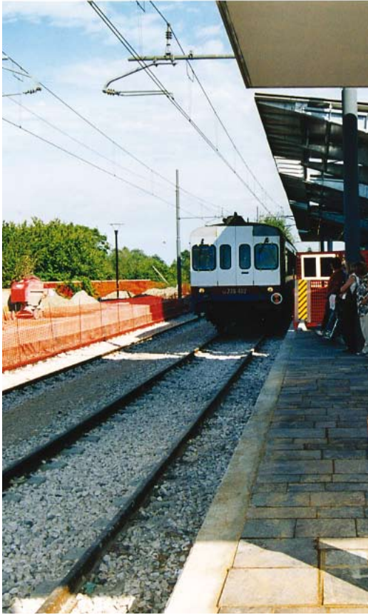
Ferrovia Suburbana Bologna – Vignola - 2003
