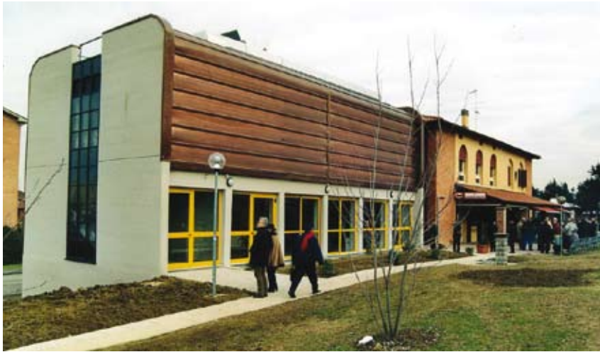
Ampliamento e Ristrutturazione Centro Socio-Culturale " Sandro Pertini" 2004
