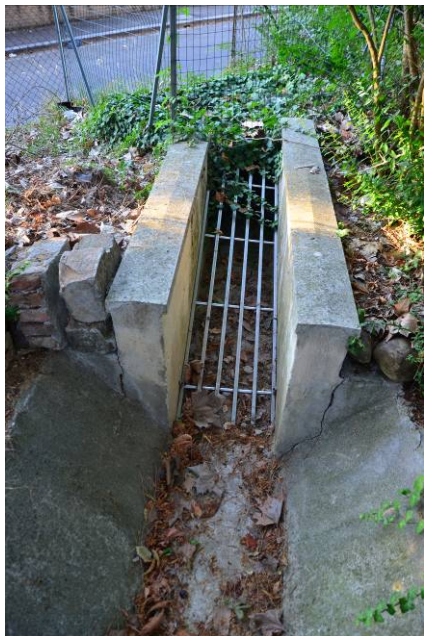
Foto 1 manufatto di immissione al pozzetto sotto via Gesso.
